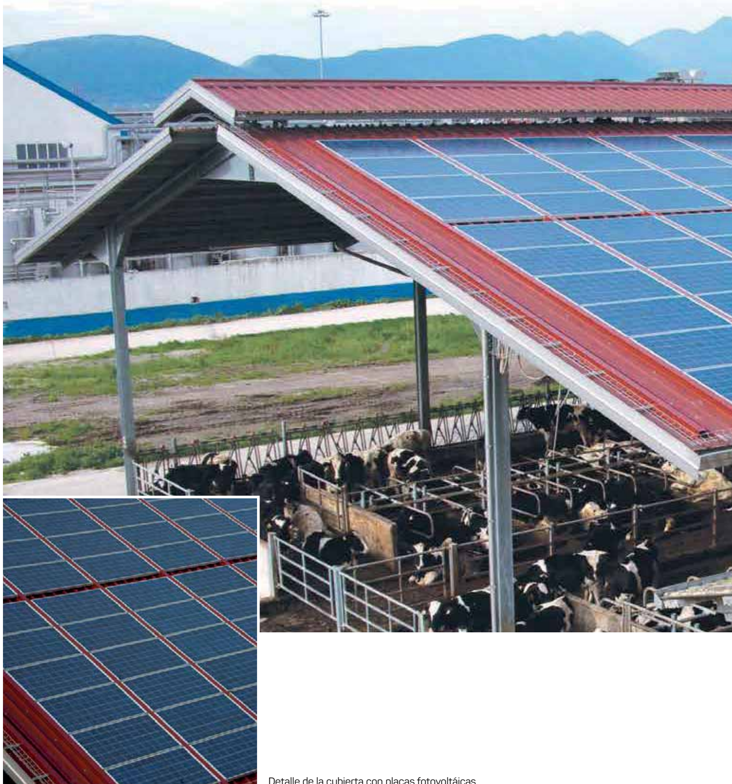
Detalle de la cubierta con placas fotovoltaicas
